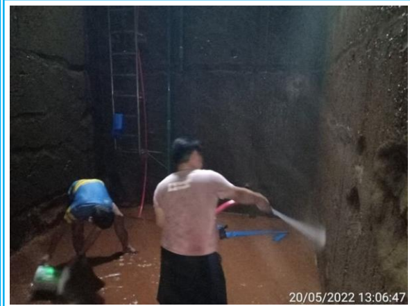
รูปที่ 3-23 การล้างเก็บน้ำสำรองของโครงการ
