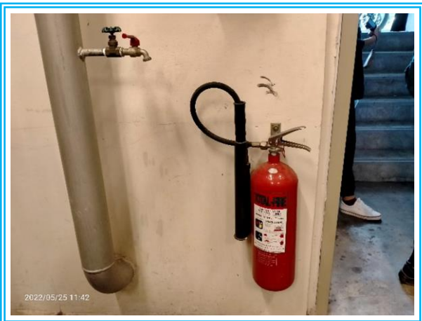
รูปที่ 3-46 ถังดับเพลิงชนิดก๊าซคาร์บอนไดออกไซด์
