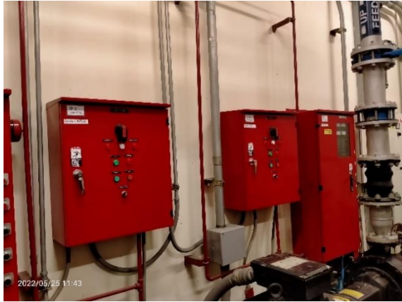
รูปที่ 2.3-13 ระบบน้ำสำรองดับเพลิงและเครื่องสูบน้ำดับเพลิง
