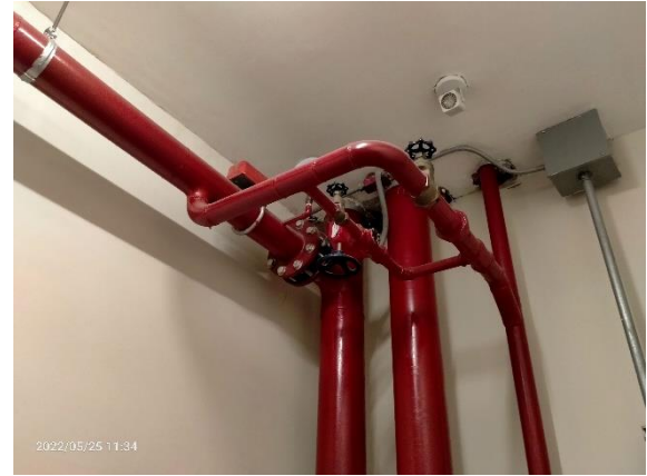
รูปที่ 2.3-14 ระบบท่อน้ำดับเพลิงหรือท่ออื่น
