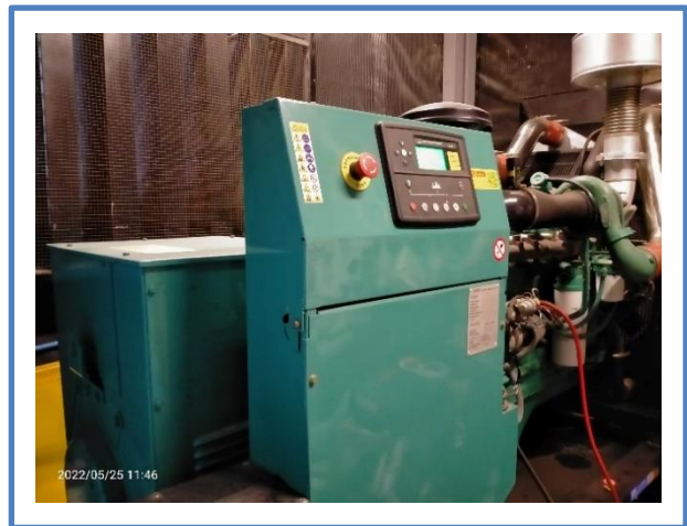
รูปที่ 2.3-10 เครื่องกำเนิดไฟฟ้าสำรอง
