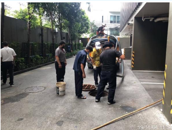
รูปที่ 3-38 การสูบน้ำส่วนเกินจากระบบบำบัดน้ำเสียไปกำจัด
