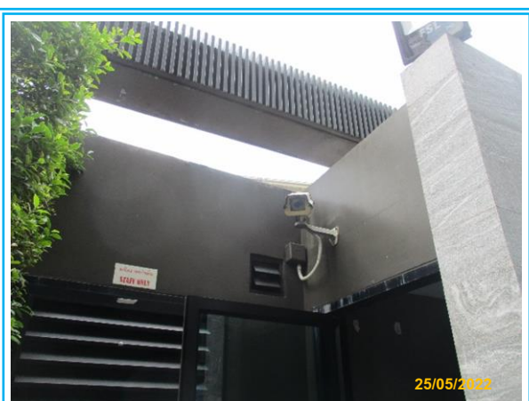
รูปที่ 3-60 ระบบโทรทัศน์วงจรปิด (CCTV) บริเวณป้อมเจ้าหน้าที่รักษาความปลอดภัย
