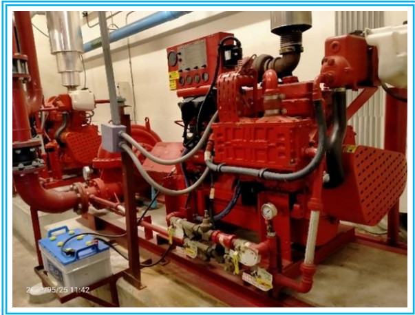
รูปที่ 3-41 ระบบปั๊มน้ำของโครงการ
