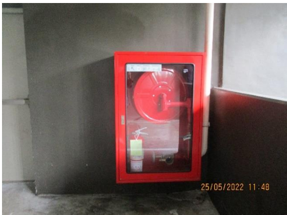
รูปที่ 2.3-17 ตู้เก็บสายฉีดน้ำดับเพลิง
