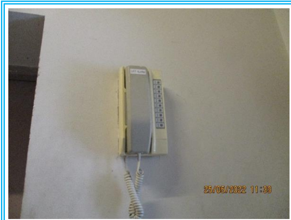
รูปที่ 3-56 โทรศัพท์ฉุกเฉินบริเวณโถงหน้าลิฟต์หนีไฟ
