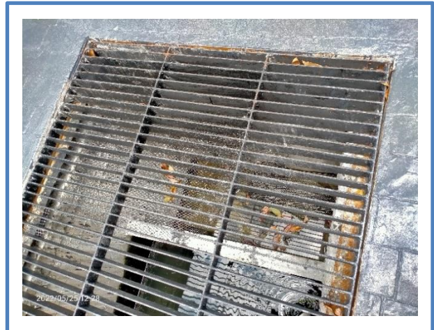
รูปที่ 2.3-3 ตะแกรงดักขยะมูลฝอย
