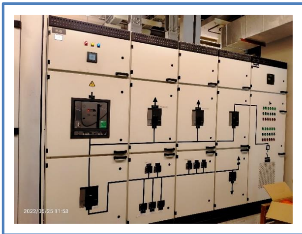
รูปที่ 2.3-9 แผงจ่ายไฟหลัก (Main Distribution Board, MDB)
